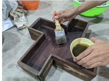
Gambar 3. 26 Pengolesan Minyak Bekisting pada Cetakan
