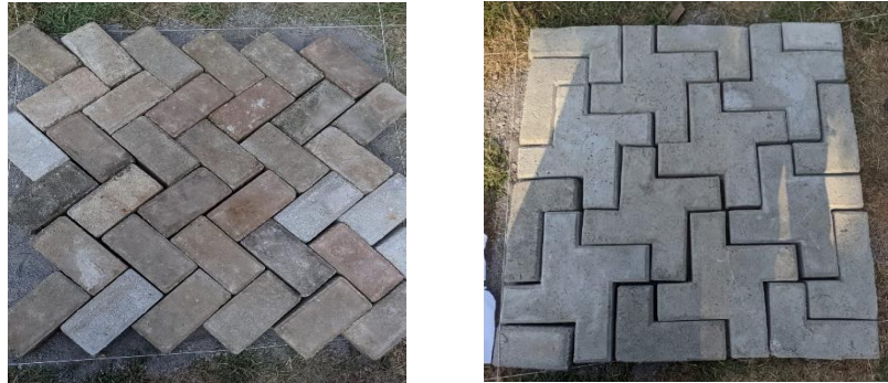
Gambar 3. 41 Hasil Pemasangan Paving block
