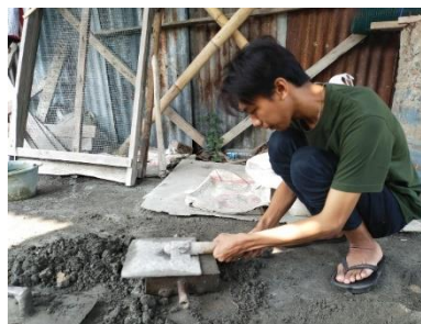
Gambar 3. 20 Pemadatan Paving block dengan Cara Manual
