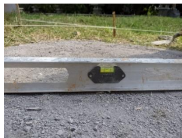
Gambar 3. 40 Pengecekan Kedataran Hamparan Pasir
