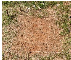
Gambar 3. 36 Tempat Pengujian Pemasangan Paving block
