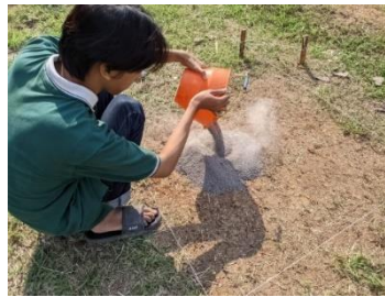
Gambar 3. 38 Pemberian Alas Pasir Pada Lokasi Pemasangan
