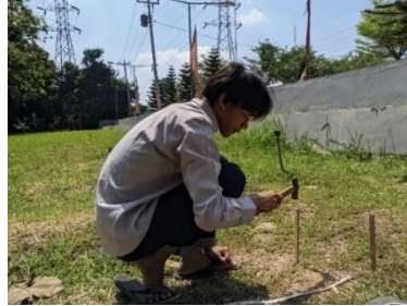
Gambar 3. 37 Pemasangan Penanda Pada Area Pemasangan
