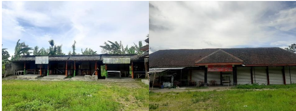
Gambar 1. 4 Warung-warung yang sudah tidak beroperasi
