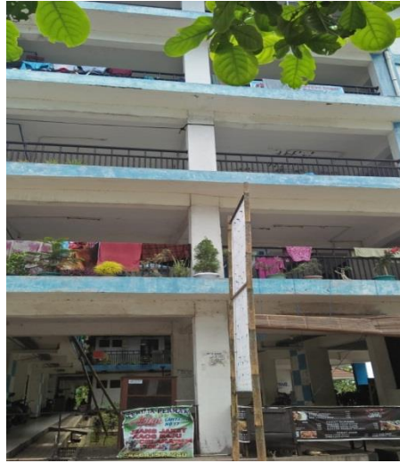
Gambar 1.3 Gedung Rusunawa Kudu
