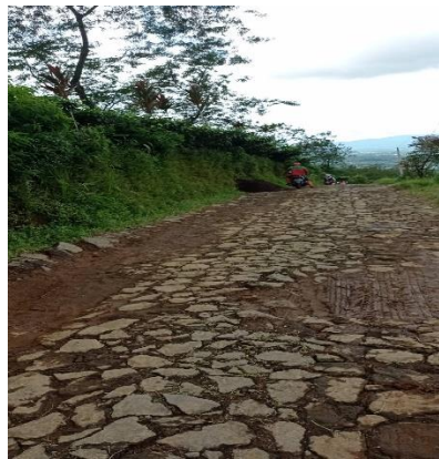
Gambar 2. 13 Akses Jalan Menuju Wisata Alam Seroja Sumber : Dokumen Pribadi, 2022
