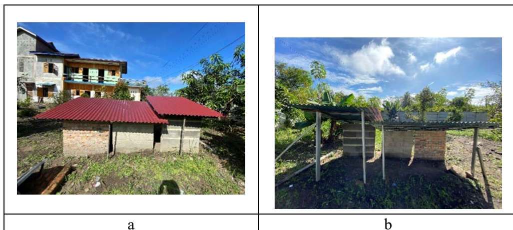
Foto 4.4 Konstruksi Dinding Menggunakan Tritisan
