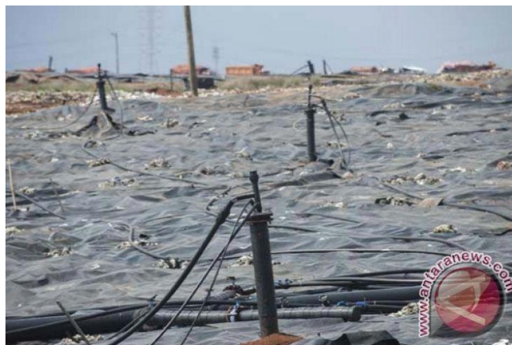
Gambar 2.26 Instalasi pipa di TPST Bantar Gebang
