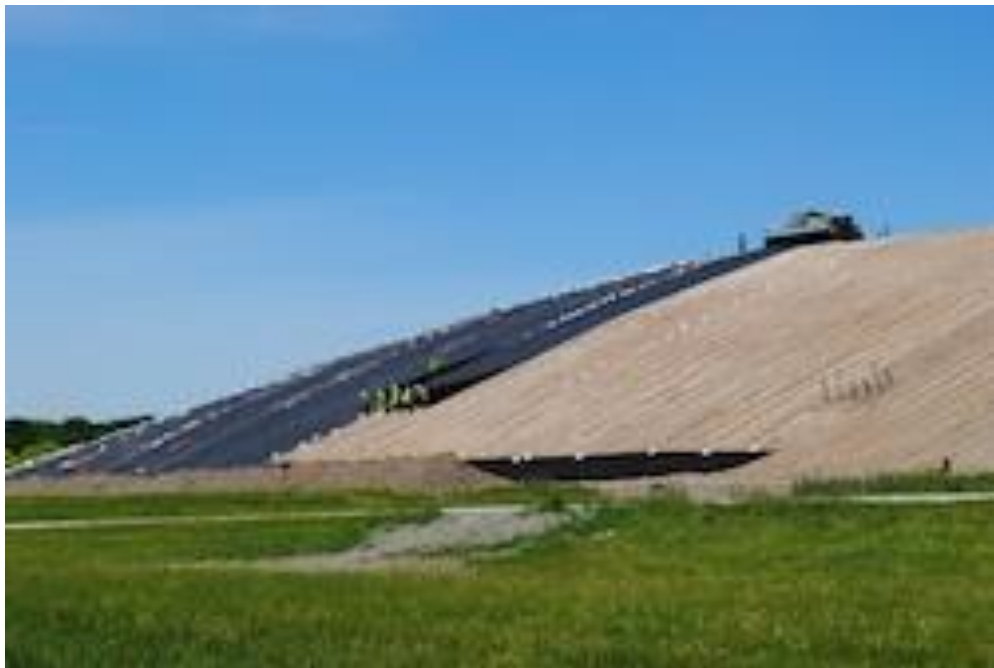
Gambar 2.30 Pemasangan capping pada sebuah sanitary landfill
