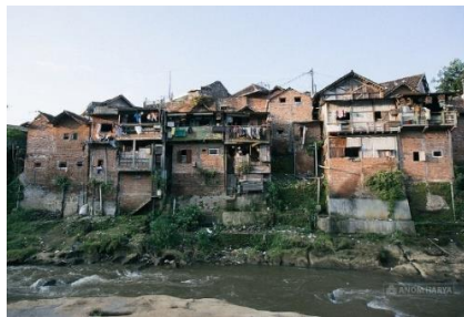
Gambar 2. 4 Keadaan Kampung Pelangi Sebelum Proses Renovasi
