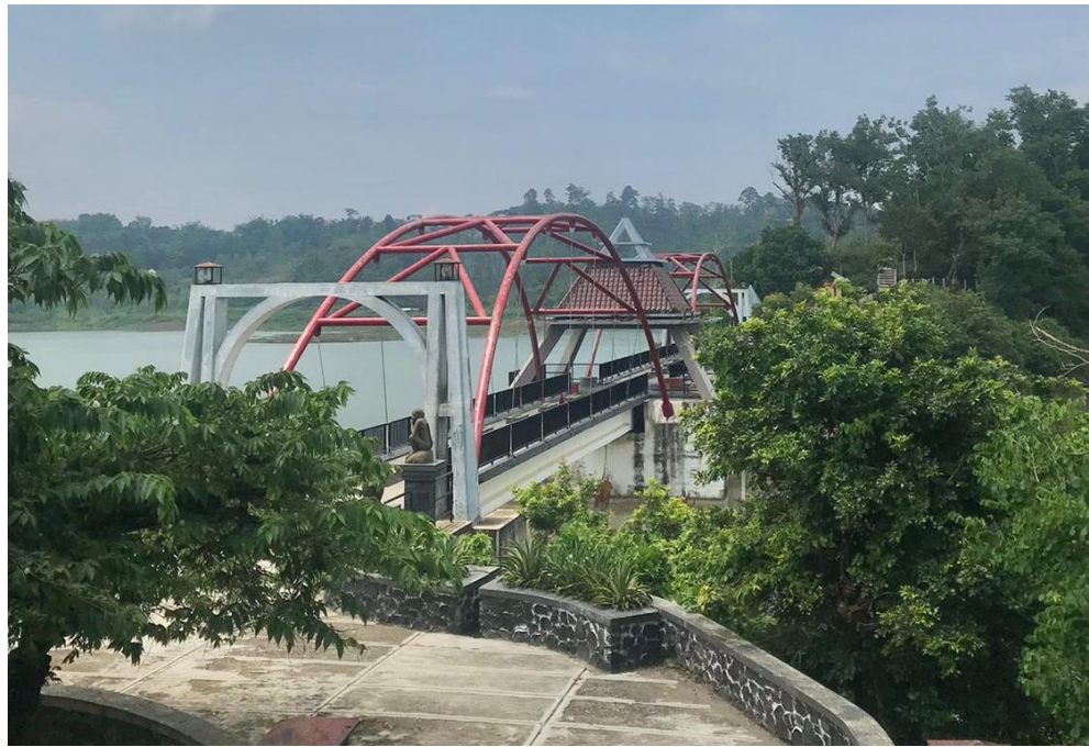
Gambar 2.7 Waduk Jatibarang Sumber: Dokumentasi Peneliti (2023)
