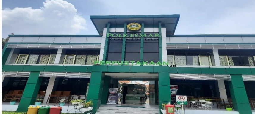
Gambar 2. 1 Bangunan Unit Perpustakaan Poltekkes Kemenkes Semarang dari Depan
