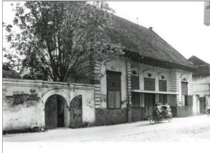
Gambar 1.1 Gedung Kantor Dewan pertama yang telah ditinggalkan.
