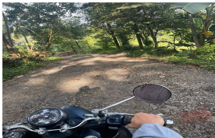
Gambar 2. 2 Kondisi jalan menuju Desa Longkeyang
