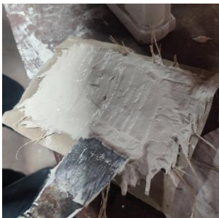
Gambar 3. 28. Ratakan gypsum hingga permukaan rata
