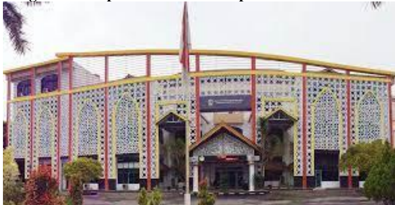
Gambar 2.1 Gedung Dinas Perpustakaan dan Arsip Provinsi Sumatera Utara
