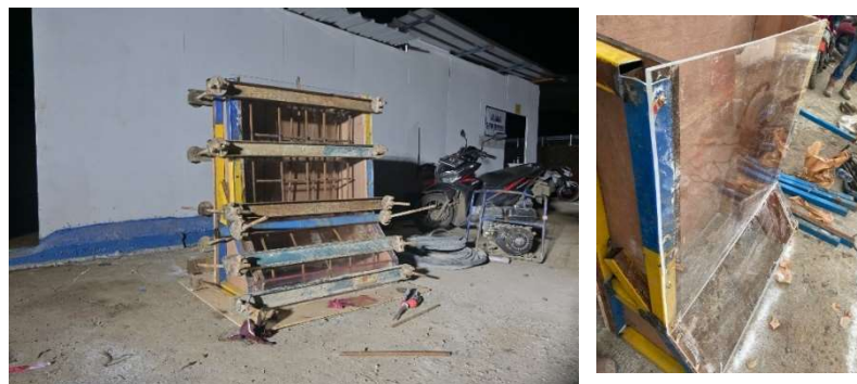
Gambar 3.3 Perakitan Bekisting
