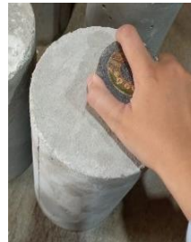
Gambar 3. 57 Beton di gosok dengan batu gosok
